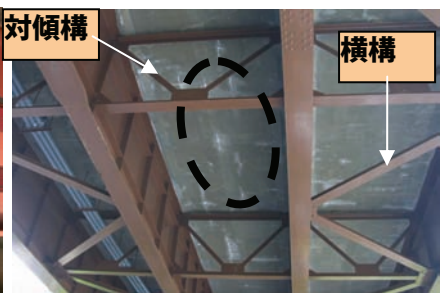
IV 床版のひびわれ
