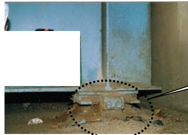
II 支承の機能障害（本体の腐食）
