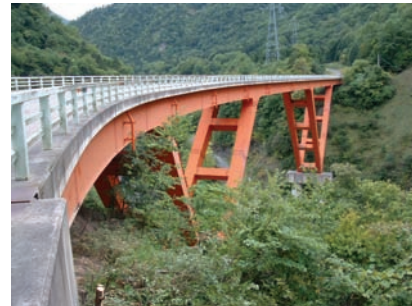
鋼ラーメン橋 (方杖ラーメン橋)
