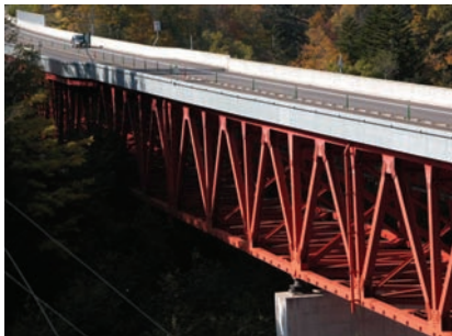
トラス橋 (上路式トラス橋)
