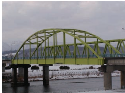
アーチ橋 (下路式ランガー桁橋)
