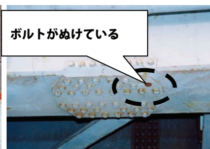
VI ボルトの脱落
