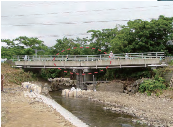
変状した橋梁 [提供:北海道開発局]
