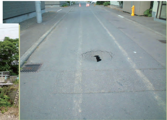
道路の陥没 [提供:札幌市]
