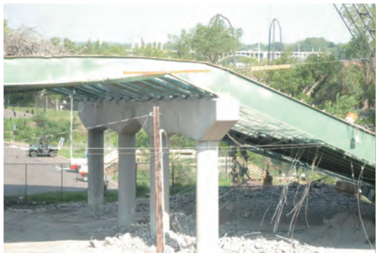
折れた橋の例(海外)
