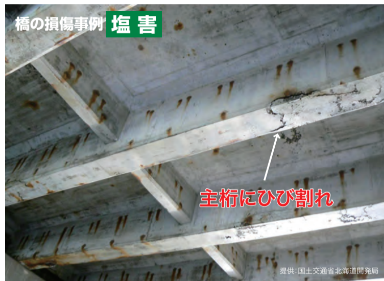
海岸沿いなどの橋で、塩分がコンクリート内に侵入することにより、鉄筋が腐食・膨張し、損傷発生
