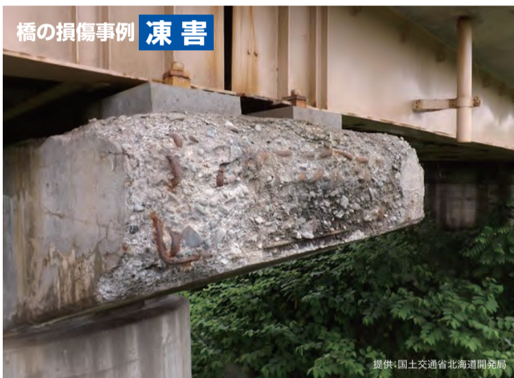
水の凍結融解の繰り返しにより、コンクリート部材が剥離し、損傷発生
