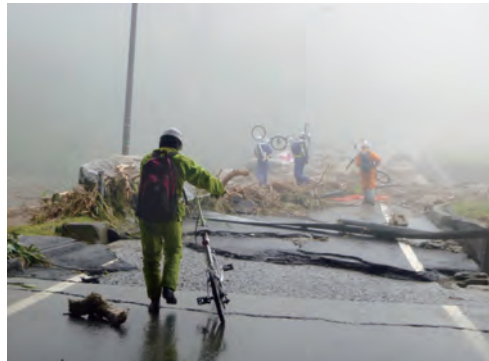
一般国道274号日高町 被災現場踏査
