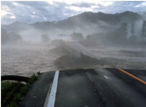
一般国道274号日高町 千呂露橋の流失 台風10号による被災(2016年8月)
